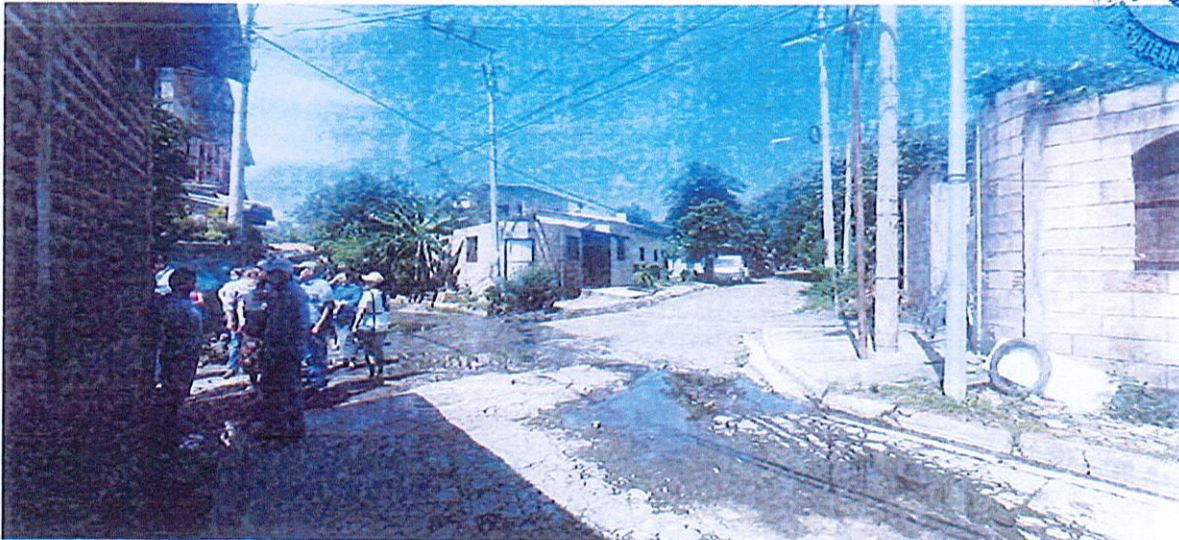
FOTOGRAFIA N°2: Se observan los cruces de la Av. Número 4 y Calle antigua a Santa Rosa de Lima (Calle en desuso con un ancho de 7.20 metros de linderó a linderó) las casas de La Comunidad Las Margaritas.
