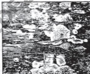
Figura 5. DETERIORO: Daño de la madera por agentes patógenos e insectos, debido a las circunstancias ambientales (agua, sol, otros).
