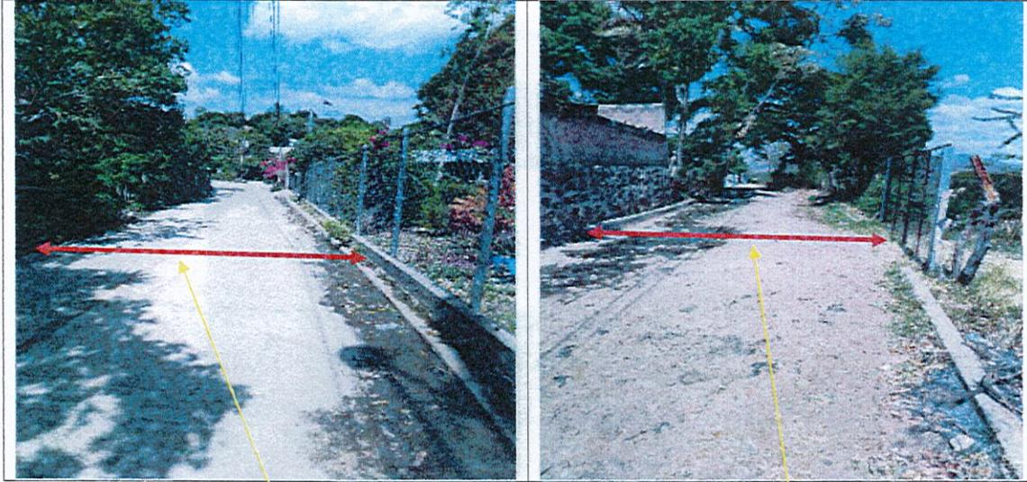
FOTO N°3 Y N°4: ANCHO DE CALLE DE TRAMO INTERMEDIO CON UNA DISTANCIA DE 5.13 METROS A 4.55 METROS.
